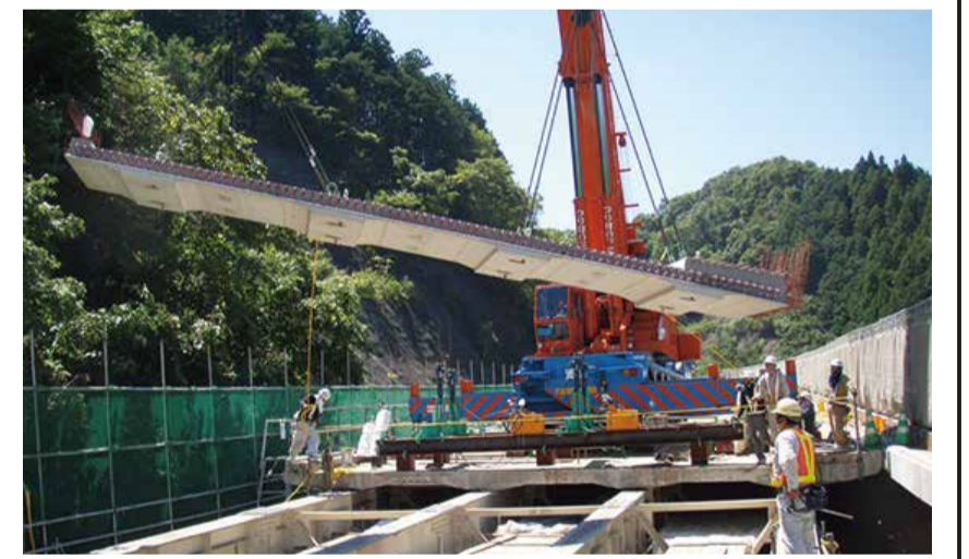
プレストレストコンクリート床版架設
