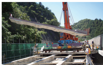
プレストレストコンクリート床版架設
