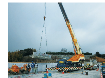
◀既設壁高欄の撤去イメージ
