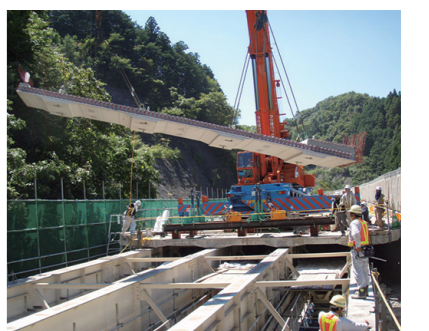
プレストレストコンクリート床版架設
