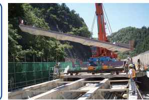
プレストレストコンクリート床版架設
